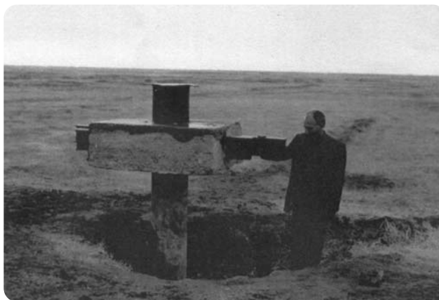
نگاره ۳- نشست زمین در دشت آبرفتی سرجان که به علت بهره‌برداری از آب‌های زیرزمینی است. اینگونه نشست، دور بیشتر دشت‌ها دیده شده و اندازه آن در یک دشت نیز تفاوت می‌کند که بایستی علت‌یابی بشود.
